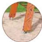
Poteaux bois lamellé-collé structurés de 100x236mm
